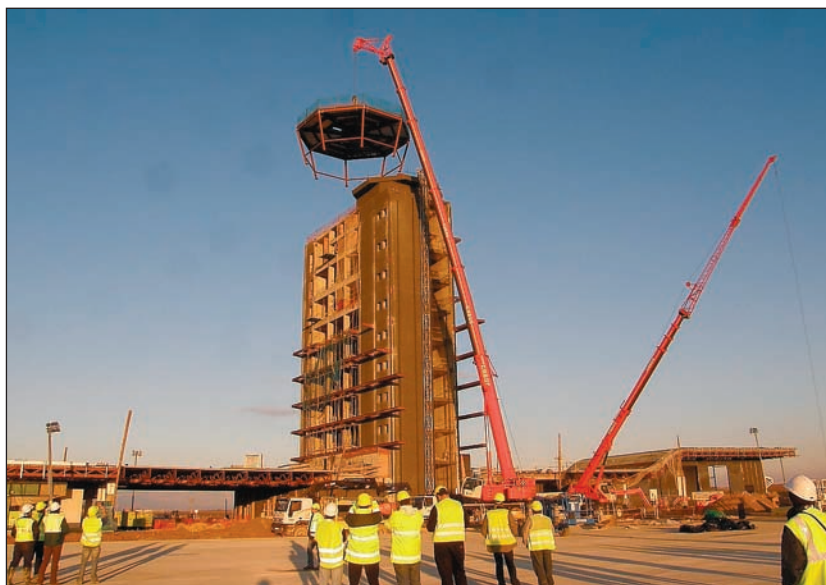
Obres de construcció de l'aeroport de Lleida-Alguaire.
